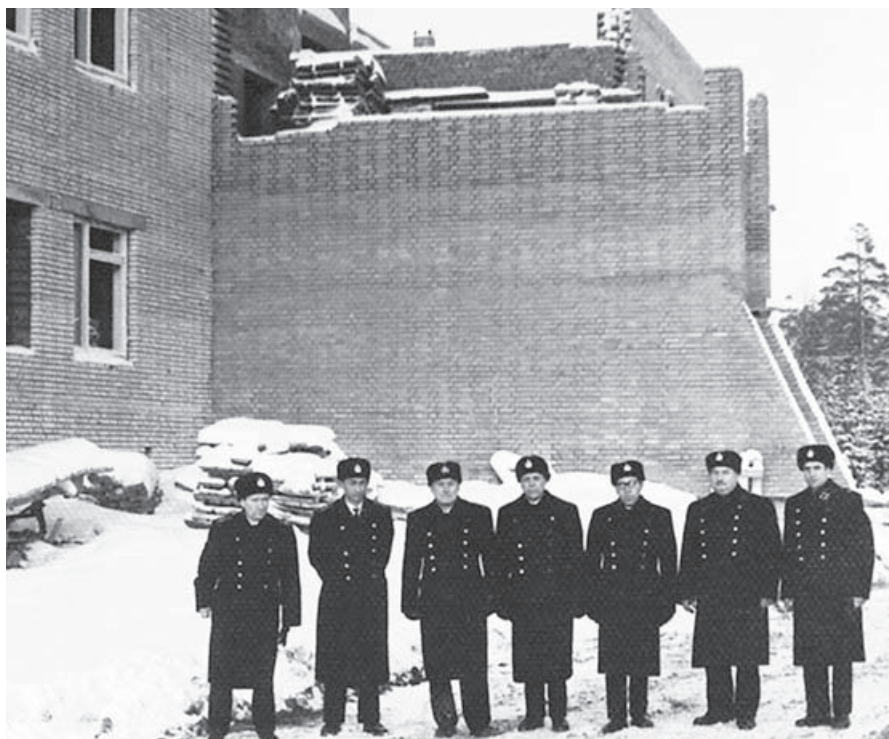
Первый состав командования части на фоне строящегося корпуса «А». (Февраль 1973 г.)
