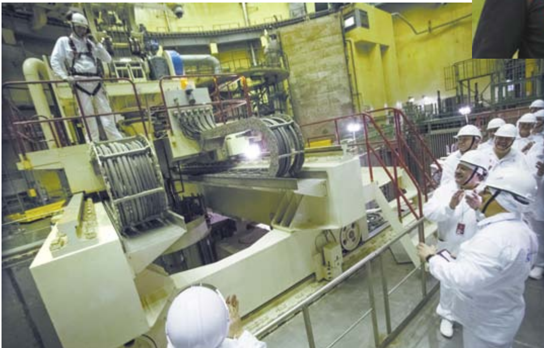
Начались пусковые работы на новом энергоблоке ЛАЭС
