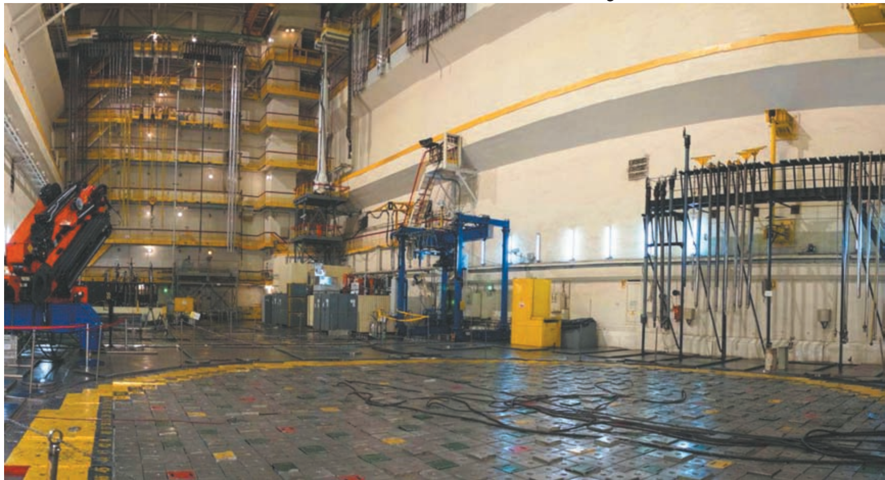
Главный зал реакторного цеха
