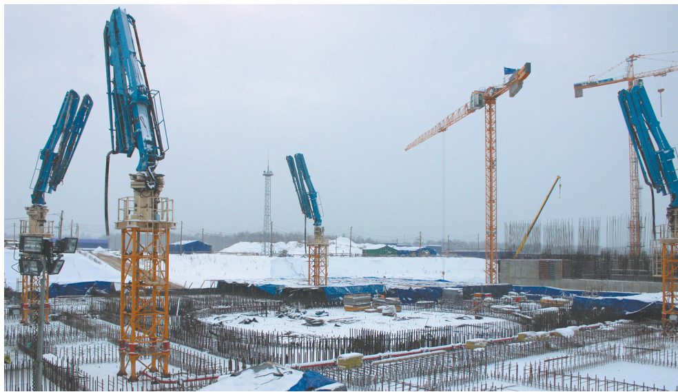
На возведение стен первого яруса уйдет 3000 тонн арматуры
