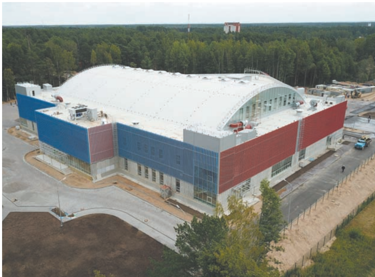
Сейчас специалисты полностью завершили строительные работы. Они занимаются наладкой оборудования
