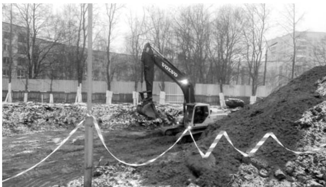
На огороженной забором стройплощадке спилены почти все деревья и вырыт котлован
