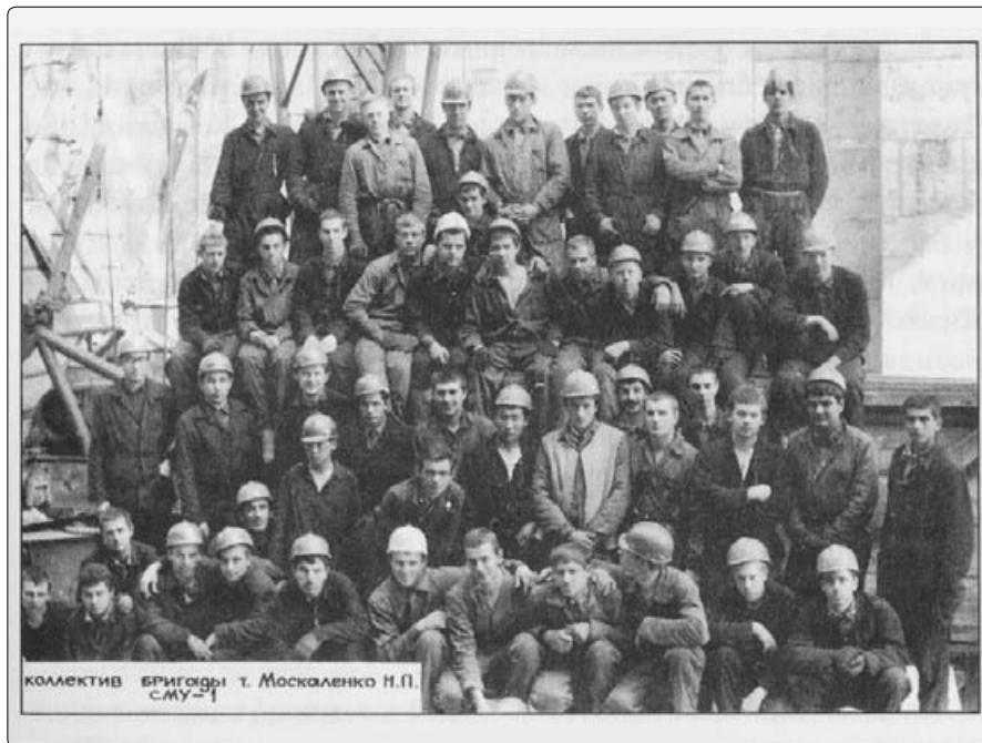
Сентябрь 1980 года. Военные строители — участники графитовой кладки 4 энергоблока ЛАЭС
