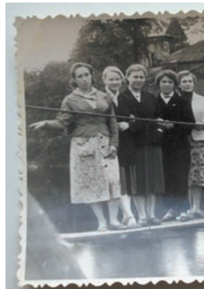
На мосту к рыбокомбинату — отделочники, строившие первые дома в Сосновом Боре
