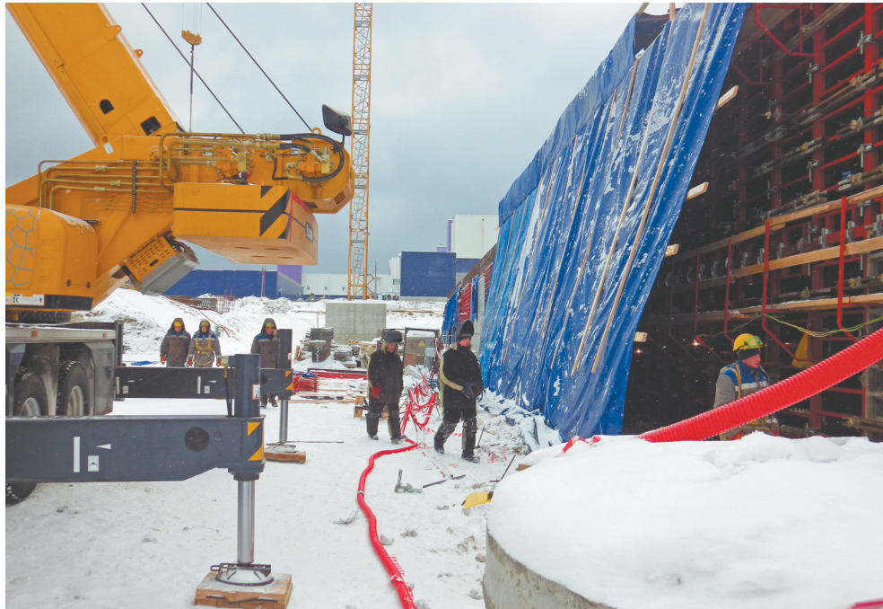
На здании реактора уже замкнули контурные стены
