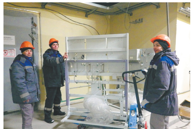
В МФР подрядная организация — АО «Сосновоборэлектромонтаж» — ведет монтаж электро- и технологического оборудования
