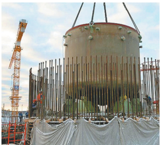
Установка ловушки расплава на энергоблоке Ленинградской АЭС-2
