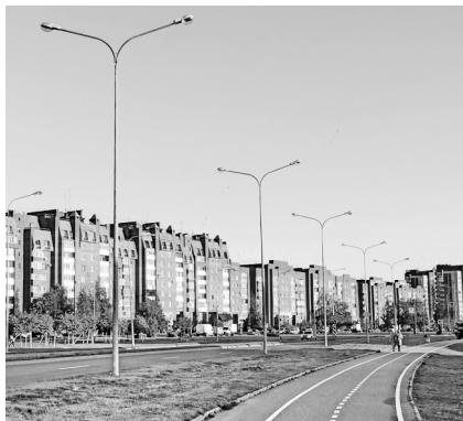
Все фонари на улице Ленинградской и проспекте Героев оборудуют специальными контроллерами
