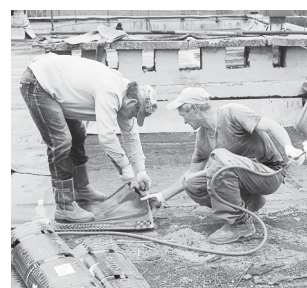
объекты. Сданы работы по ремонту кровли в домах
