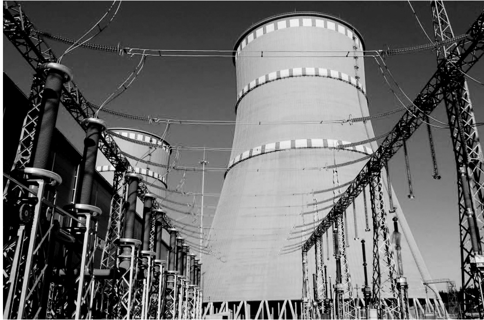
Энергоснабжение — основа строительного процесса. Без него невозможна работа любой строительной площадки
