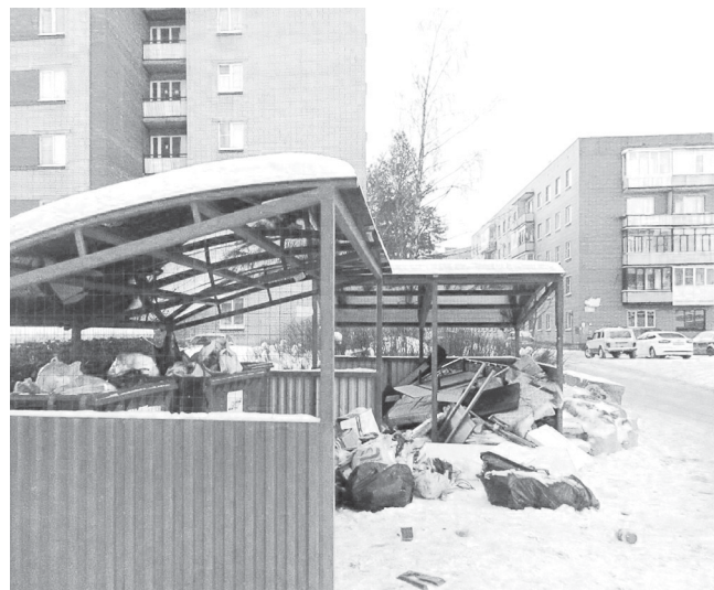
У каждой площадки есть бетонное основание, крыша, борта из металлопрофиля, а внутри навеса предусмотрены места для контейнеров и складирования крупногабаритных отходов
