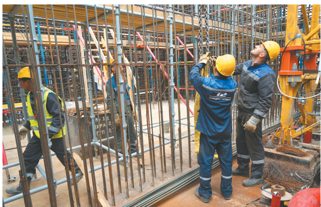
Уже завершается возведение стен до нулевой отметки, полным ходом идет армирование и бетонирование перекрытий
