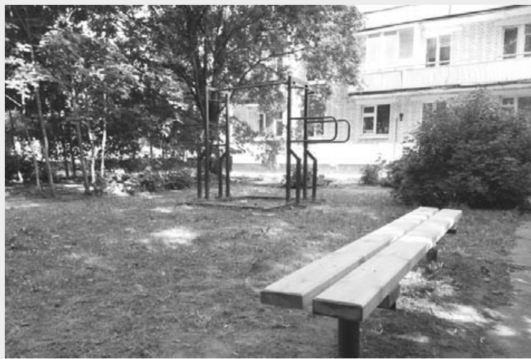
Скамейка была отремонтирована и стоит до сих пор
