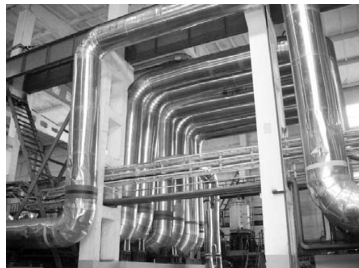
По этим трубам очищенная и подогретая вода потечет в наши дома
