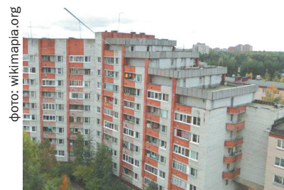
Солнечную 25А ждет ремонт фасада
