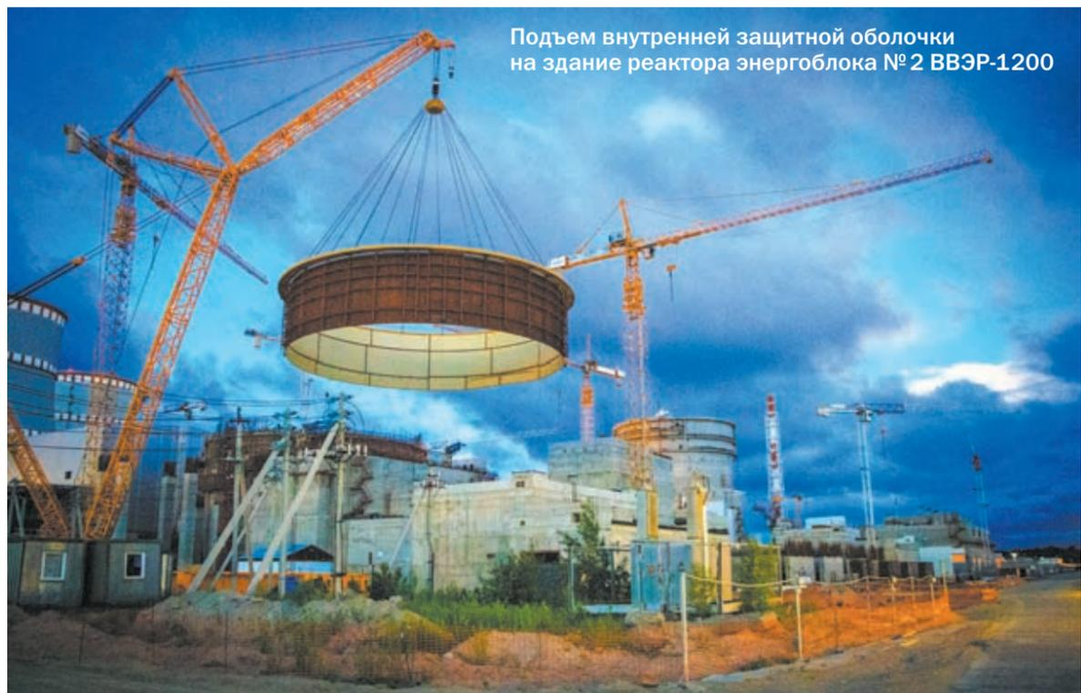
Подъем внутренней защитной оболочки на здание реактора энергоблока № 2 ВВЭР-1200
