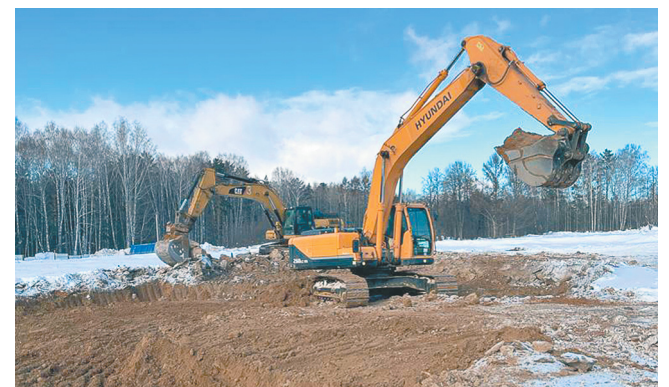
Ведется вертикальная планировка с применением бульдозеров, экскаваторов, самосвалов
