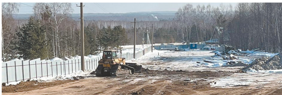
На месте строительства демонтированы старые сооружения, убраны насаждения
